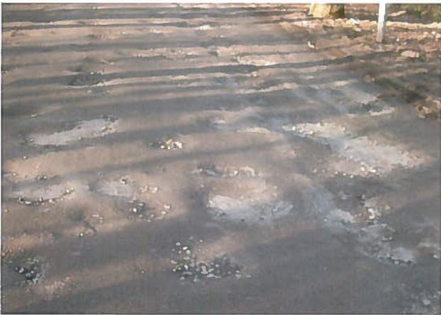
Tennen- und Wegerenovator vor dem Einsatz
